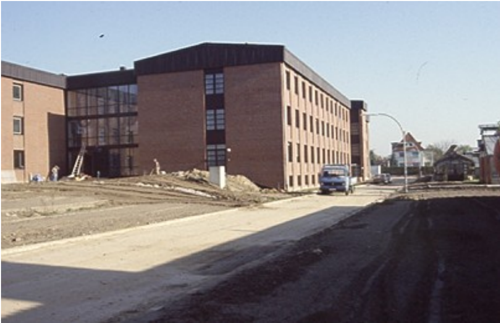
Der Institutsbau steht
