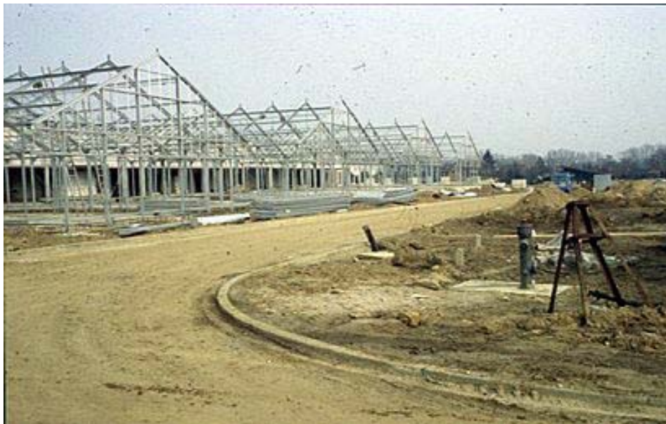
Rohbau der Gewächshäuser
