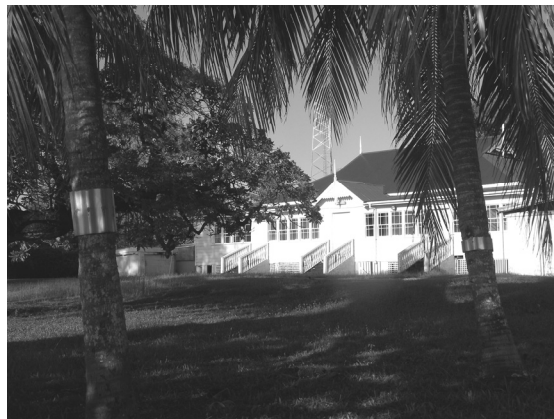
Abb. 5 Manschetten aus Aluminiumblech an Kokospalmen zur Abwehr von Schadnagern auf dem Gelände der königlichen Residenz Tau'akipulu auf Lifuka, Tonga.
