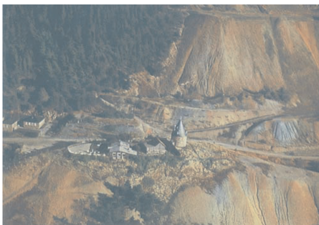
Abb. 1. Luftbild des ehemaligen Erzausstrichs und Erzabbaus am Rammelsberg bei Goslar und der damit verbundenen schwermetallbelasteten Böden (historische Ansichtskarte).
