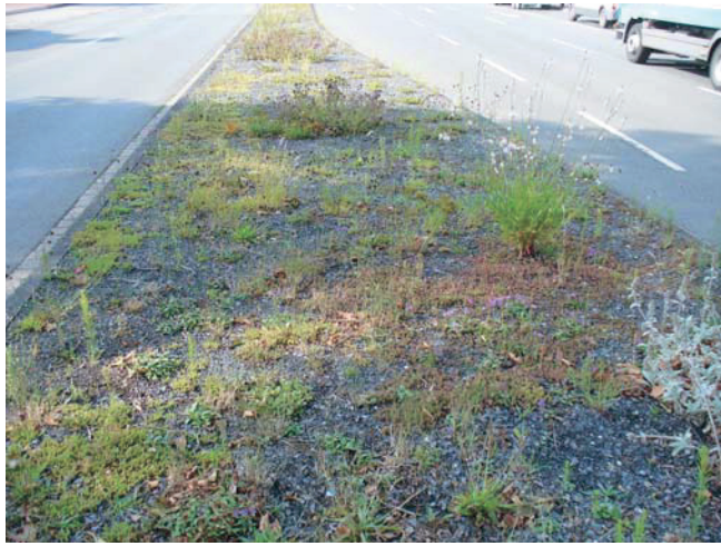
Abb. 3. Entsiegelung durch Anlage einer Schotterrasenfläche.
