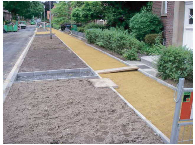
Abb. 4. Umbau eines Bürgersteigs zu Gunsten einer Rasenfläche.
