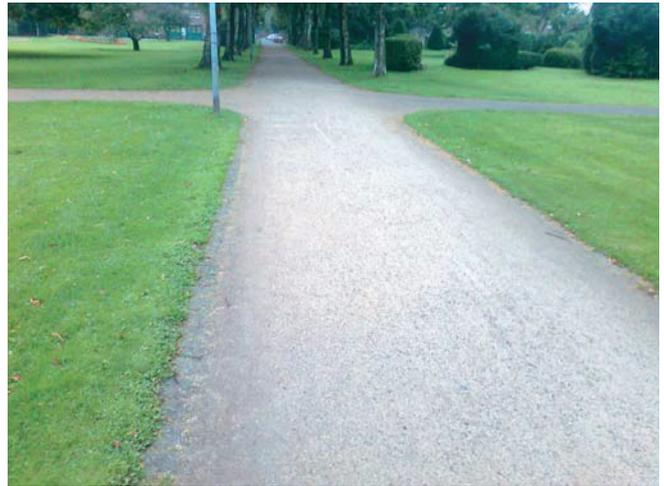
Abb. 2. Wegedecke mit Deckenmaterial Dolomitbrechsand, Einfassung aus Natursteingroßpflaster.
