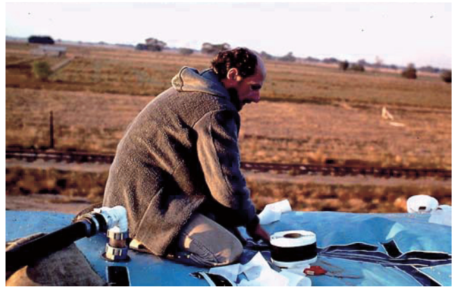
Abb. 3. Prof. Dr. REICHMUTH bei seinem einjährigen Aufenthalt in Australien im kühlen Feldeinsatz morgens um 4 Uhr auf einem mit Plastikfolie gasdicht eingeschlagenen 20 000 t-Getreidebunker bei der Vorbereitung einer Kohlendioxidbegasung, 1984.
