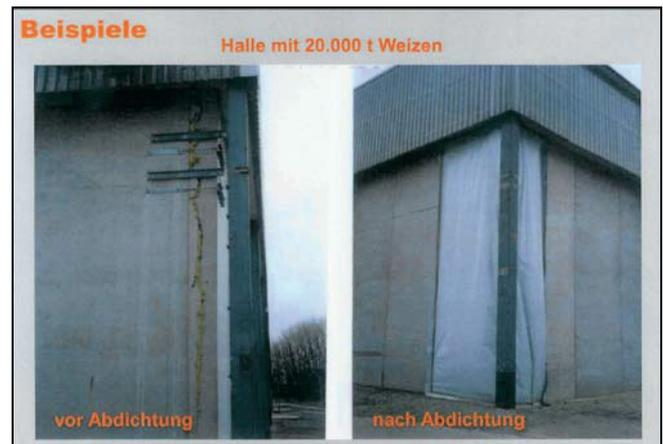
Abb. 4. Äußere Abdichtung eines Getreidelagers vor einer Behandlung mit Kohlendioxid.
