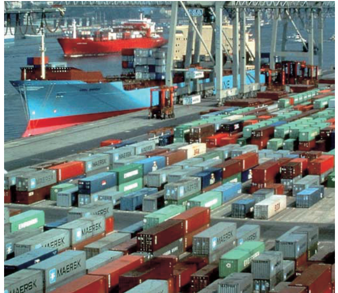
Abb. 23. Containerterminal mit Containerbrücke und einem Feeder-schiff. In 2005 wurden 8,1 Mill. TEU (20-Fuß-Container) umgeschlagen. Der Containerisierungsgrad beträgt 95%.
