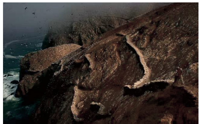
Abb. 4. Jahrhunderte alte isohypsenparallele Steinmauern zum Schutz gegen Abspülung des Rohguanos (Foto ©Tomás MUNITA).
