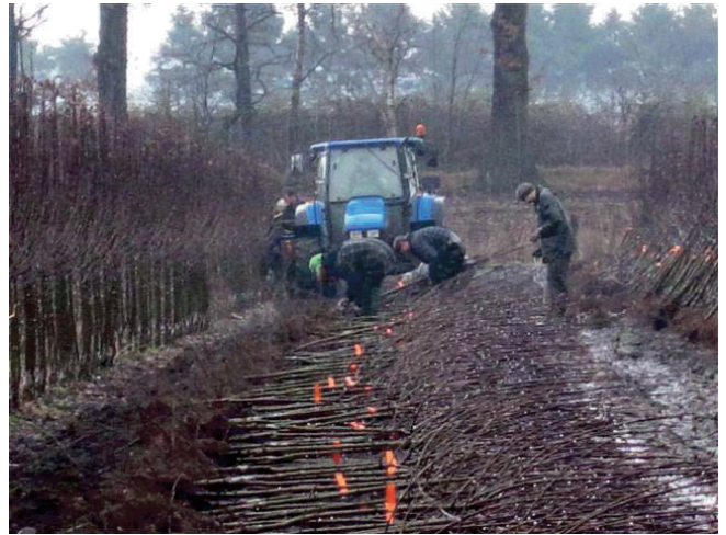
Abb. 4. Roden von 2xv Halbstämmen
