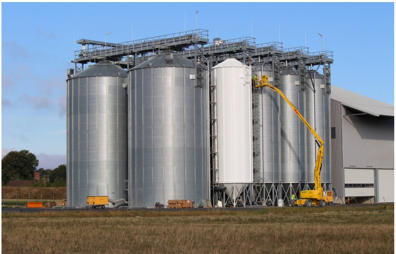
Abb. 2. Nach einem australischen Standard abgedichtete „weiße“ Silozelle (Foto: JKI/VSnet/2019)
