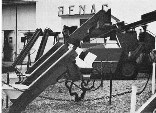
Abb. 2: Traubensammelmaschine mit senkrechter und waagrechtlicher Gutförderung und Zwischenlagerung.
